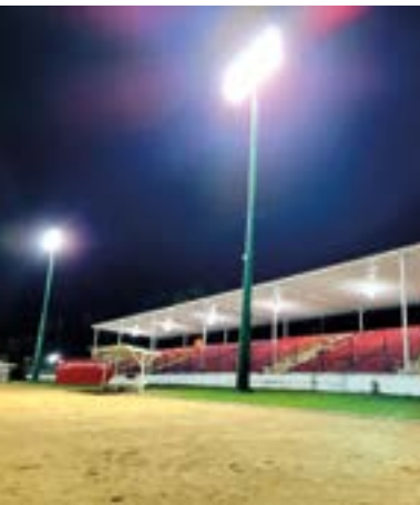
Rehabilitamos el servicio de alumbrado en 28 espacios deportivos
